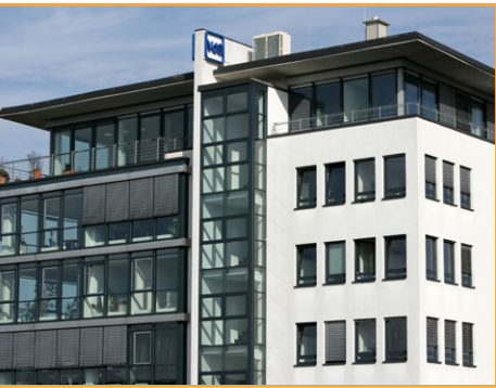
Die Richtlinie VdS 2496 für Feuerlöschanlagen wurde im August 2024 veröffentlicht.
