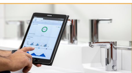
Digitale gesteuertes Spülen von Trinkwasserinstallationen senkt das Legionellenrisiko.
