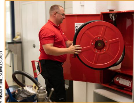
Teilprüfung einer Wandhydrantenanlage nach DIN 14462.
