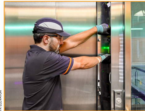
Digitale Aufzugsplattformen tragen zur Energieeinsparung im Gebäude bei.
