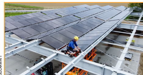
Rechtssicher baut, wer bei Überkopf-Installation auf Module mit abZ achtet.
