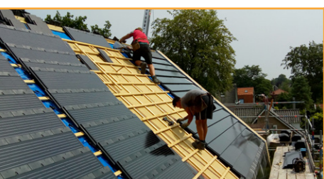
PV-Dachziegel eignen sie sich vor allem für verwinkelte und kleine Dächer.
