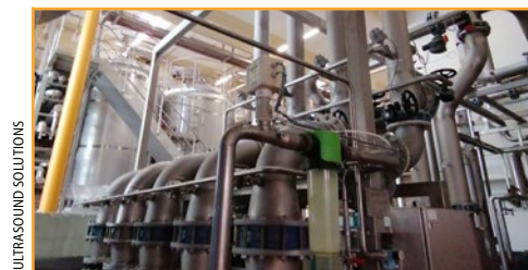
Ultraschall wirkt in allen Segmenten eines Leitungssystems gegen Keime und Biofilm.
