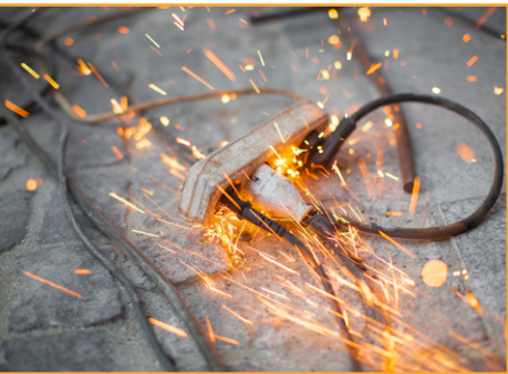
Die DIN VDE 0100-420 beschreibt Maßnahmen gegen Fehlerlichtbögen als Brandursache.
