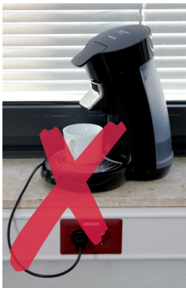
Durch nicht notstromberechtigte Verbraucher an Notstrom-Steckdosen, in unserem Beispiel eine rote Steckdose, droht eine Überlastung der Netzersatzanlage. Quelle: BBK
