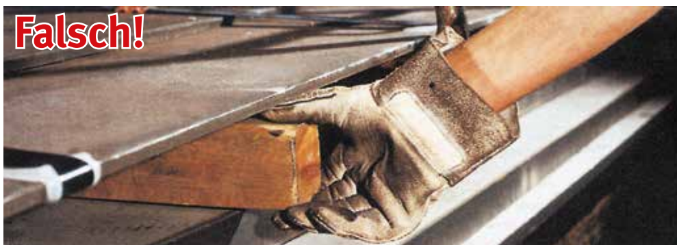
Bild 20-1: Unterlagen dürfen so nicht angefasst werden. Es besteht die Möglichkeit der Fingerquetschung
