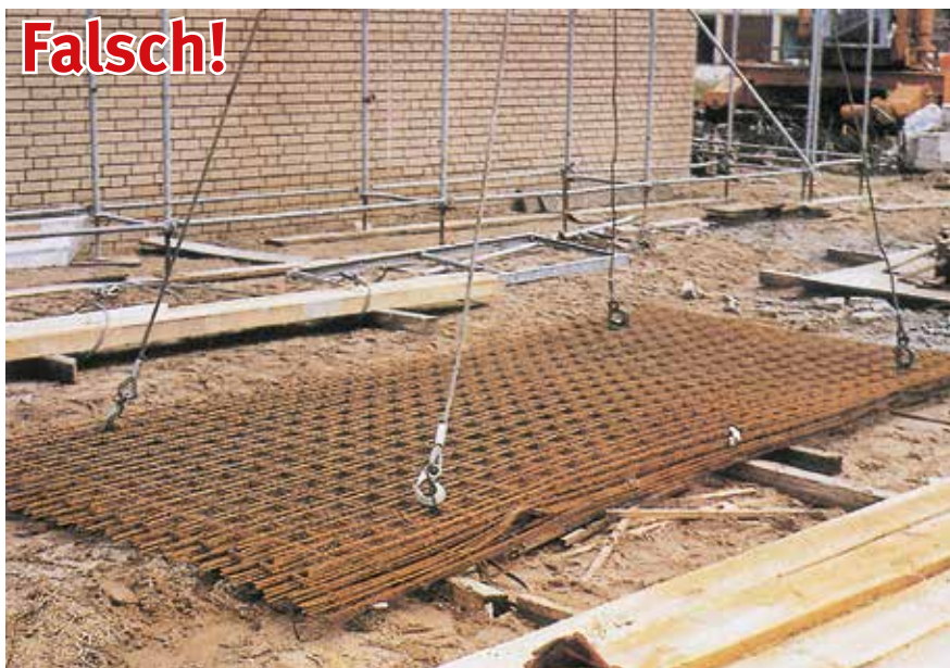
Bild 16-5: Einhängen in die Umschnürung ist lebensgefährlich!
